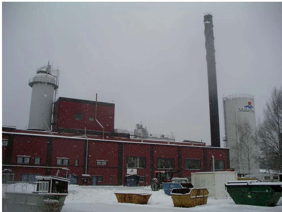
Figur 1 Hetvattencentralen i Hallstahammar, vy från söder
