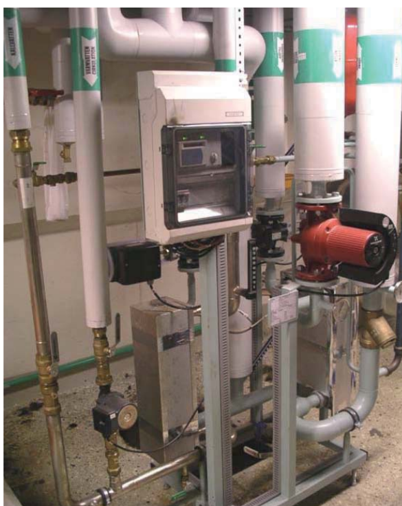
Figur 4 Inkoppling av fjärrvärme i stället för spädvatten
