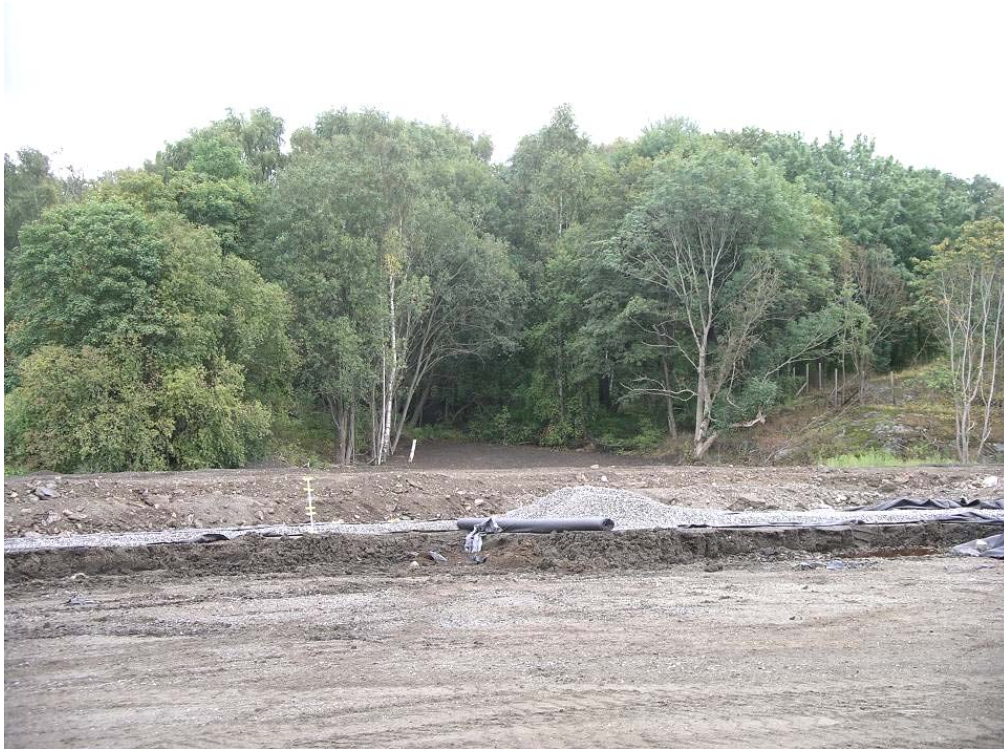
Täckning av deponi i Lövsta med flygaska från Panna 5
