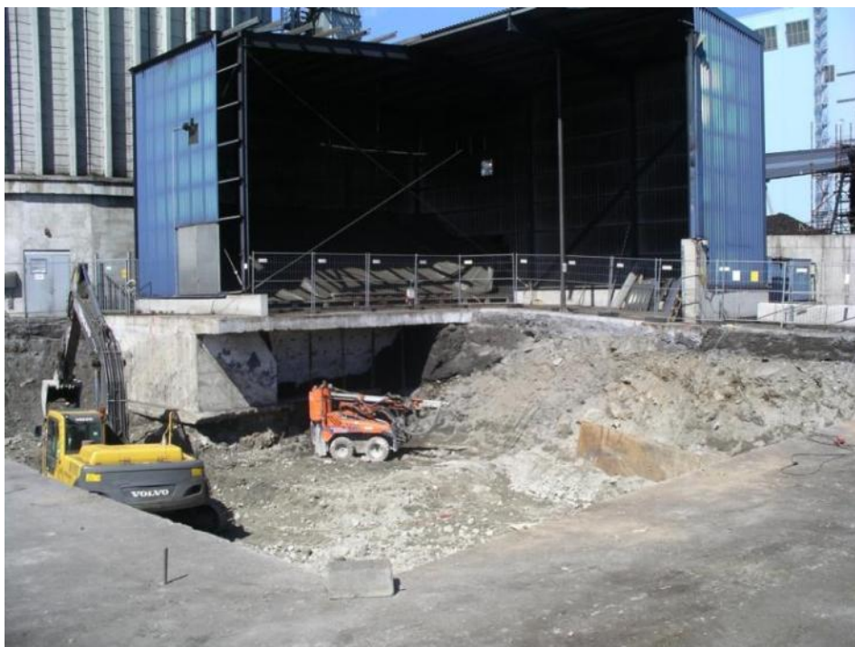
Figur 13 Schaktning inför byggnation av ny inmatningsanläggning för torra bränslen
