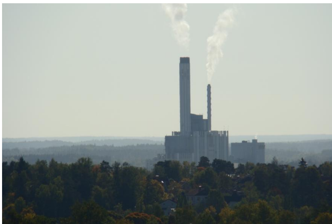
Figur 1 Kraftvärmeverket, vy från norr
