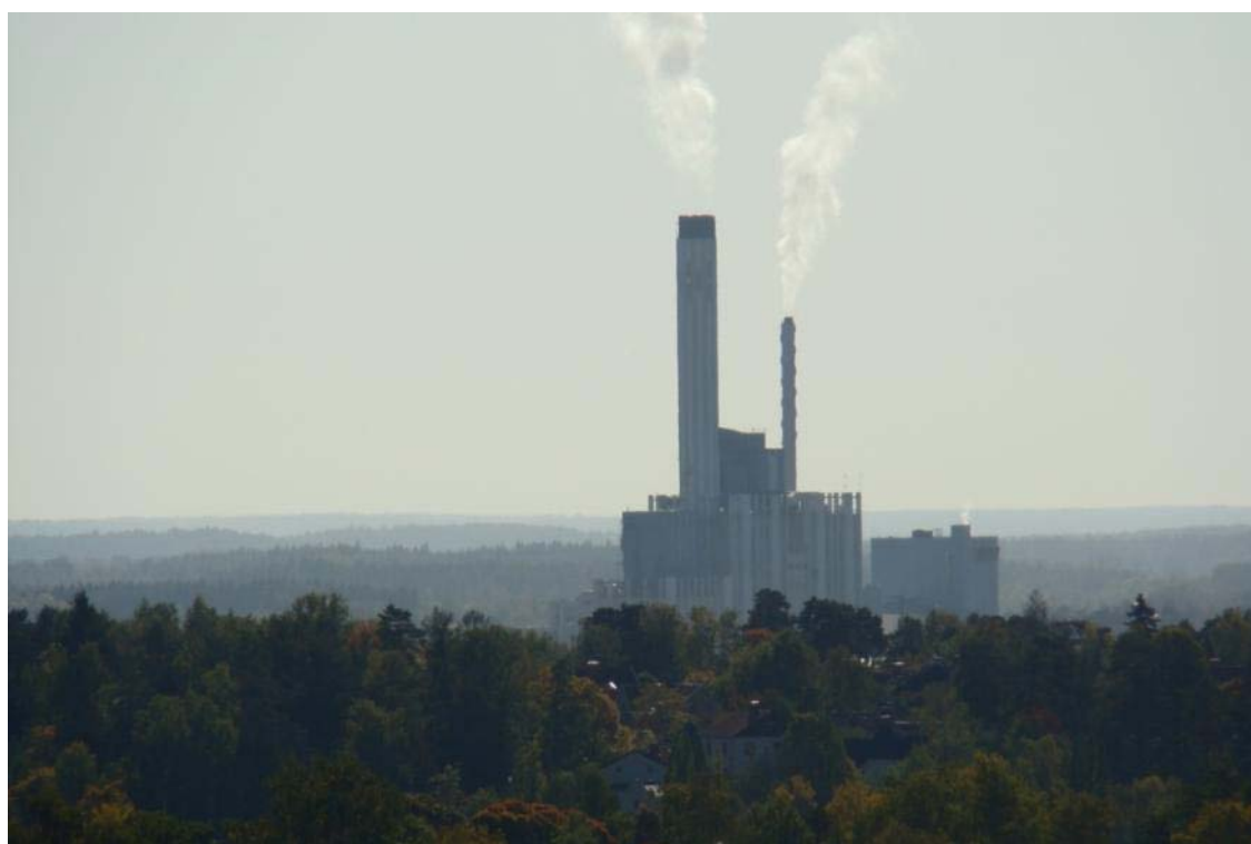
Figur 1 Kraftvärmeverket, vy från norr
