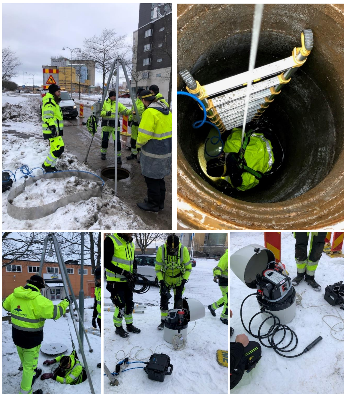
Figur 4. Provtagning i fält med flödesmätare. Foto: Sandra Burman.
