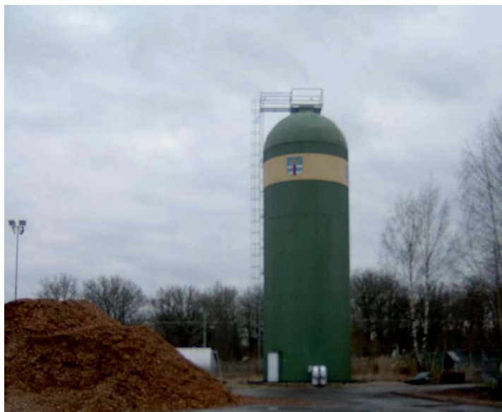
Figur 2 Hetvattenackumulator
