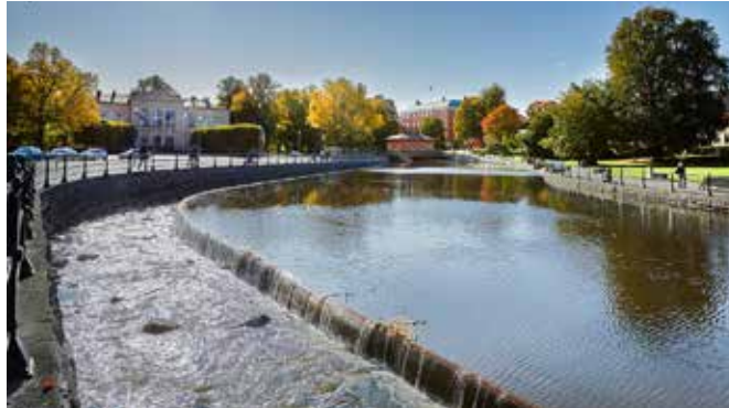
Faunapassagen vid vattenkraftstationen Turbinhuset i Västerås. Passagen gör det möjligt för fisk och andra vattenlevande organismer att vandra upp för ån.
