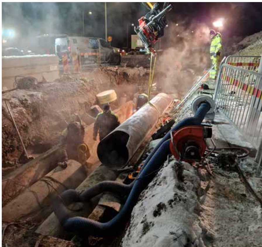
I 18 minusgrader lagar våra medarbetare på Drift och Underhåll – snabbt och effektivt – en fjärrvärmeläcka längs Sjöhagsvägen i Västerås.
