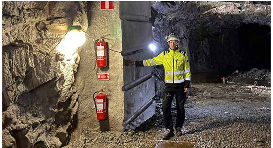
Rickard Svensson Projektledare Värme Strategi & Utveckling Projekt, de 50 år gamla oljeberggrummen som nu konverteras till varmvattenlager. Berggrummet inkluderar tre cisterner och rymmer tillsammans 300 000 kubikmeter vatten, 11 gånger mer än i ackumulatortanken, den stora termos, som byggdes 2019.
