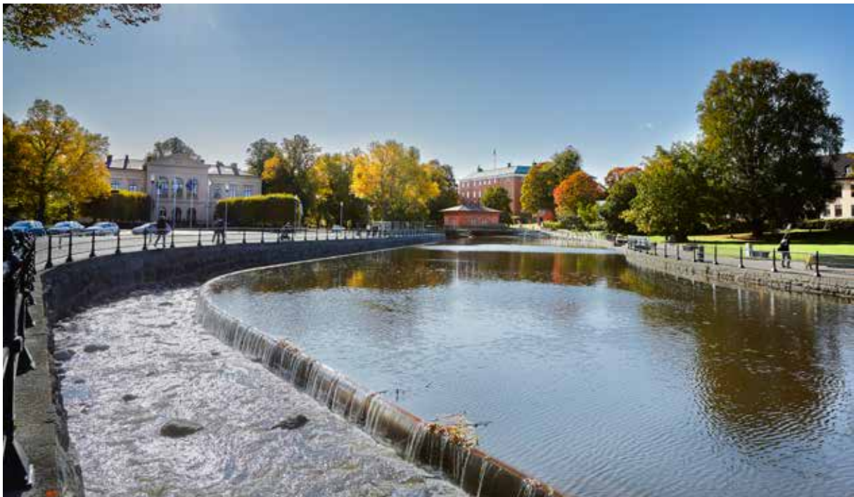
Mälarenergis faunapassage vid Turbinbron i Västerås. Förutom att passagen gynnar den biologiska mångfalden har den också till Arkitekturpris i Västmanland 2020 med motiveringen att den återställer villkoren för fisk på ett elegant sätt samt förhöjer upplevelsen av kraftverksanläggningen.
