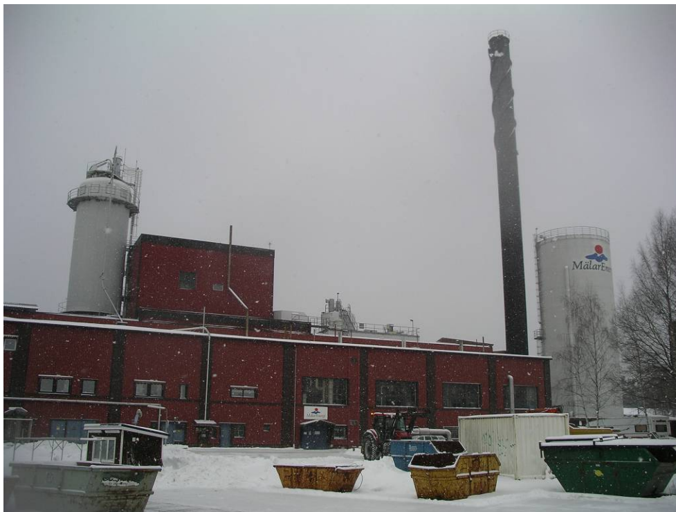
Hetvattencentralen i Hallstahammar, vy från söder
