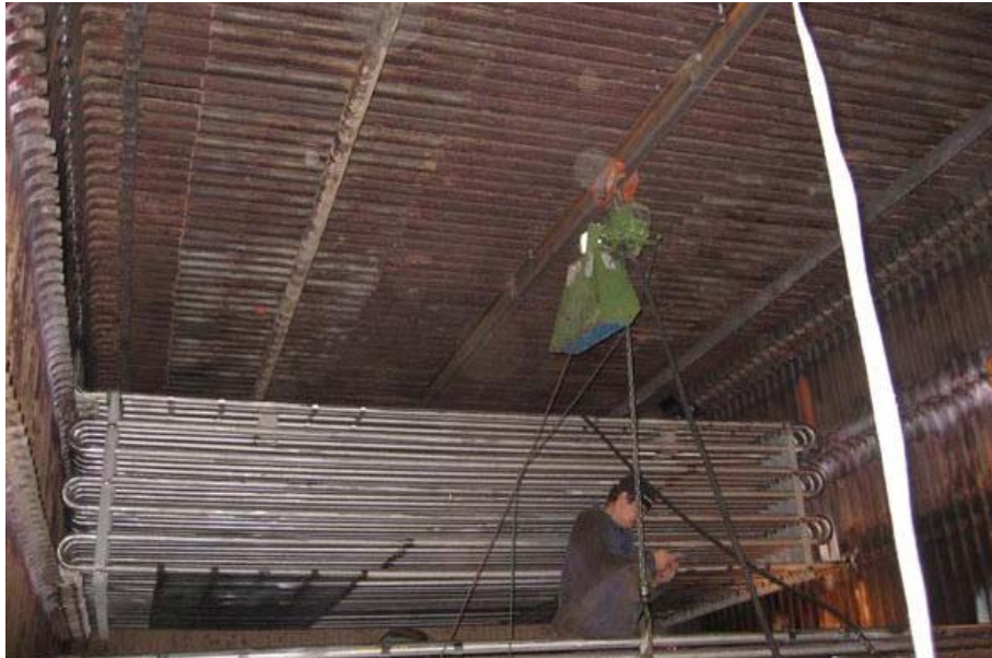
Byte av överhettare Panna 5
