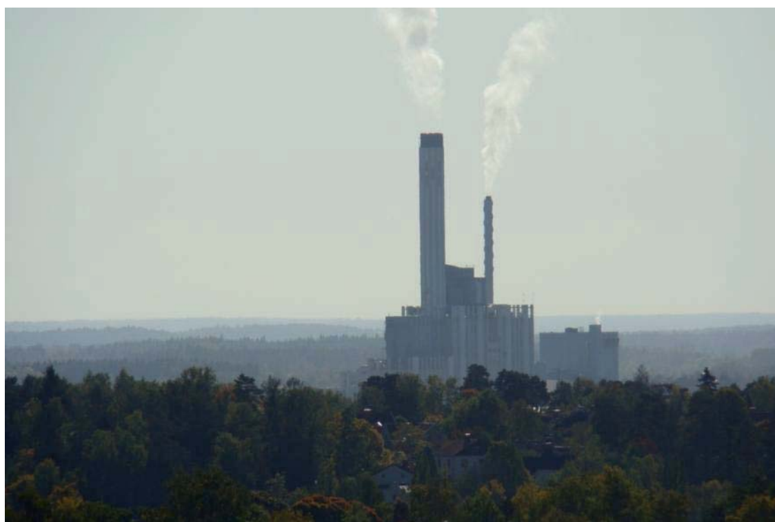
Figur 1 Kraftvärmeverket, vy från norr
