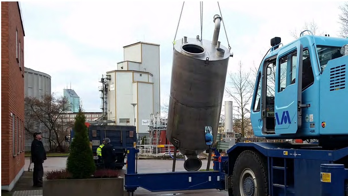
Figur 6. Externslammottagningen under byggnation. Foto: Michael Kämpenberg
