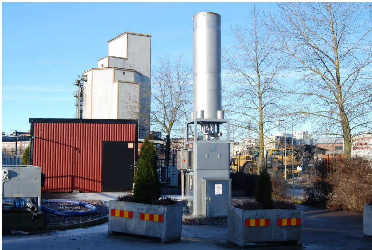
Figur 5. Klar byggnation av Gasfacklan. Foto: Michael Kämpenber.
