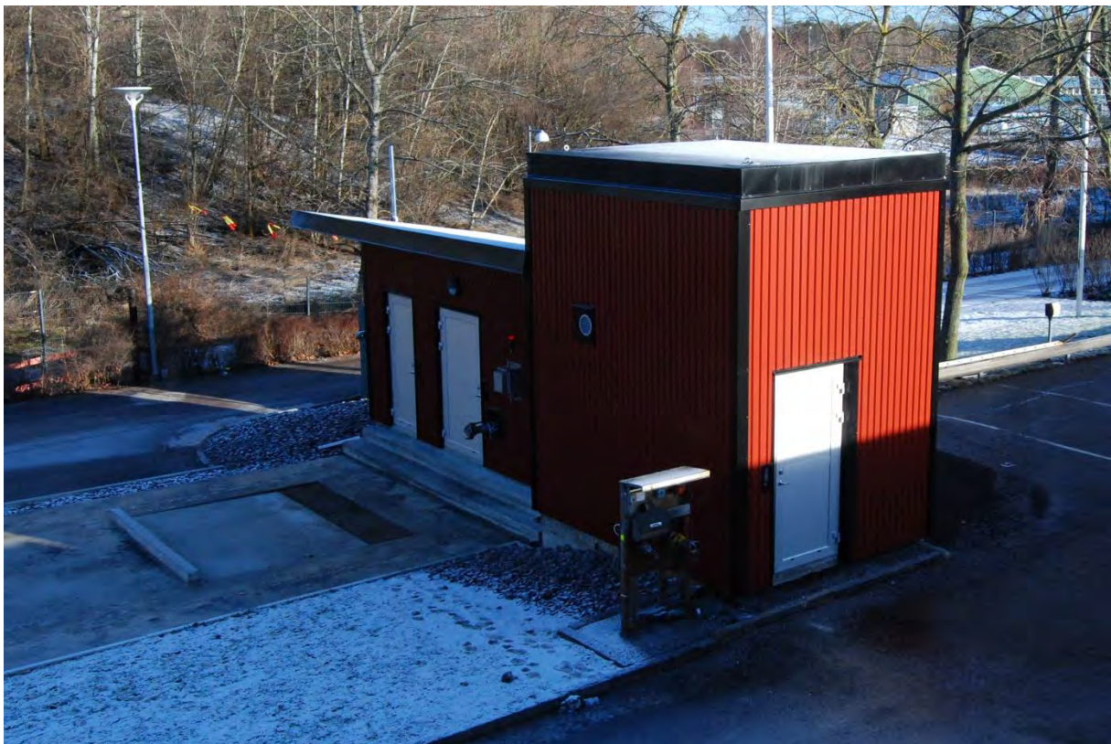
Figur 7. Klar byggnation av externslammottagningen. Foto: Michael Kämpenberg.
