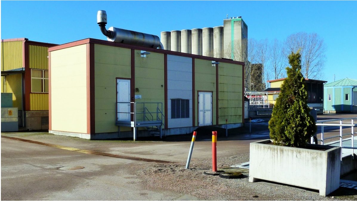
Figur 6. Byggnad för reservkraftverket. Foto: Michael Kämpenberg.
