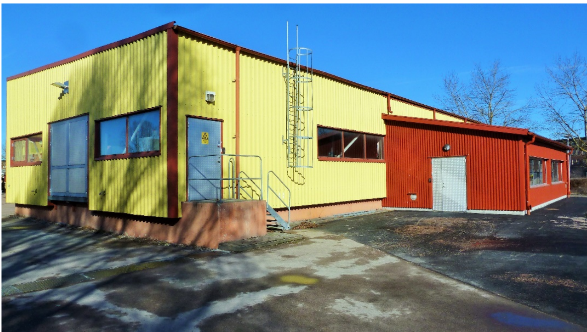
Figur 11. Ny byggnad (röd) för urpumpning och styrning av sanden. Foto: M.K.
