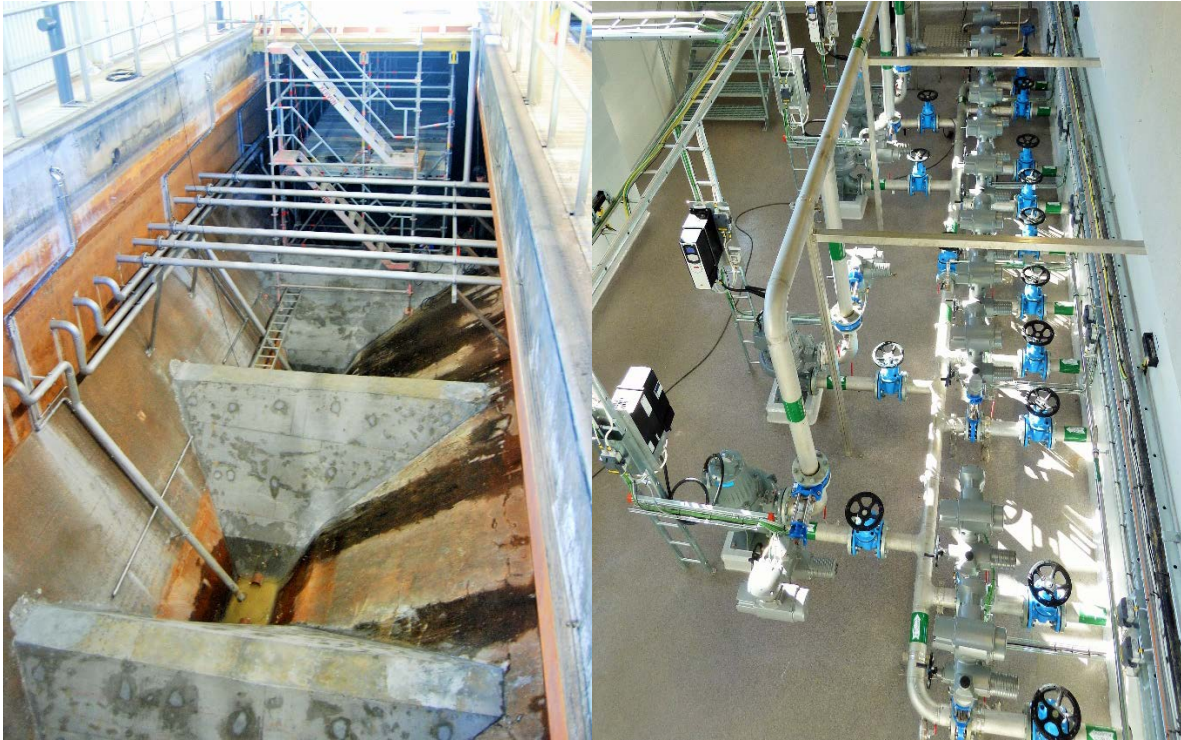
Figur 10. Tömd bassäng till vänster och nya sandfångspumpar till höger. Foto: M.K.
