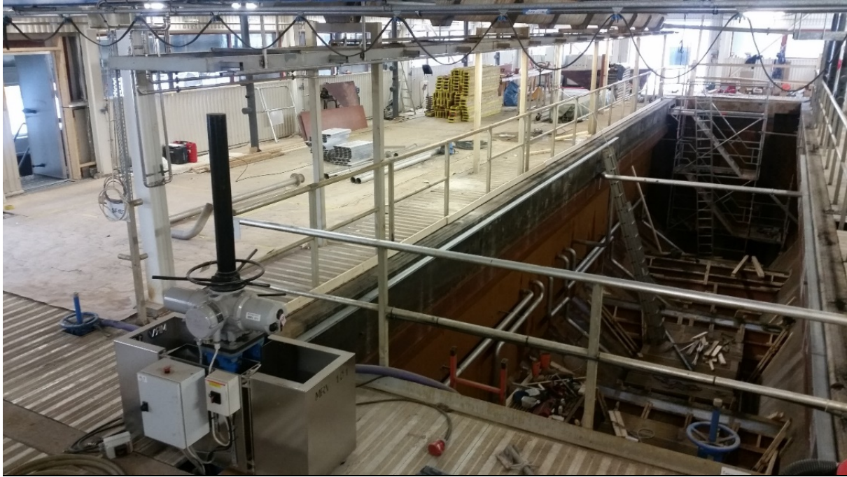
Figur 8. Renovering av bassäng i sandfånget. Foto: Michael Kämpenber.
