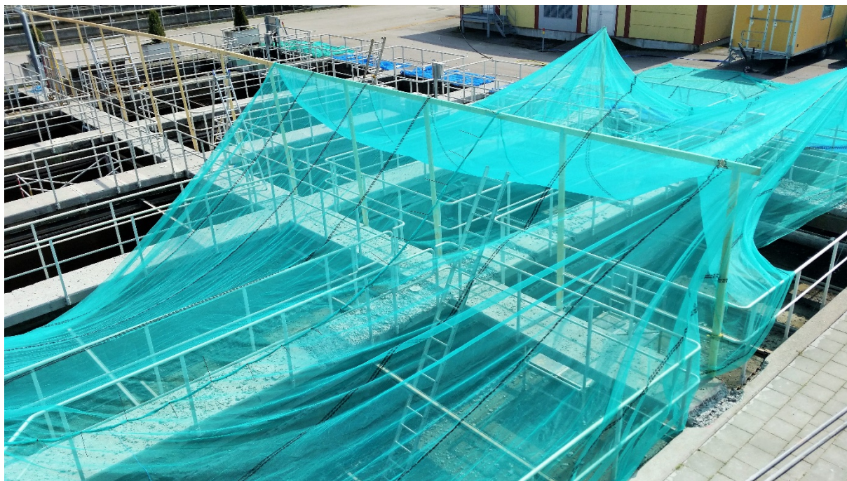
Figur 5. Betongrenovering. Foto: Michael Kämpenber.
