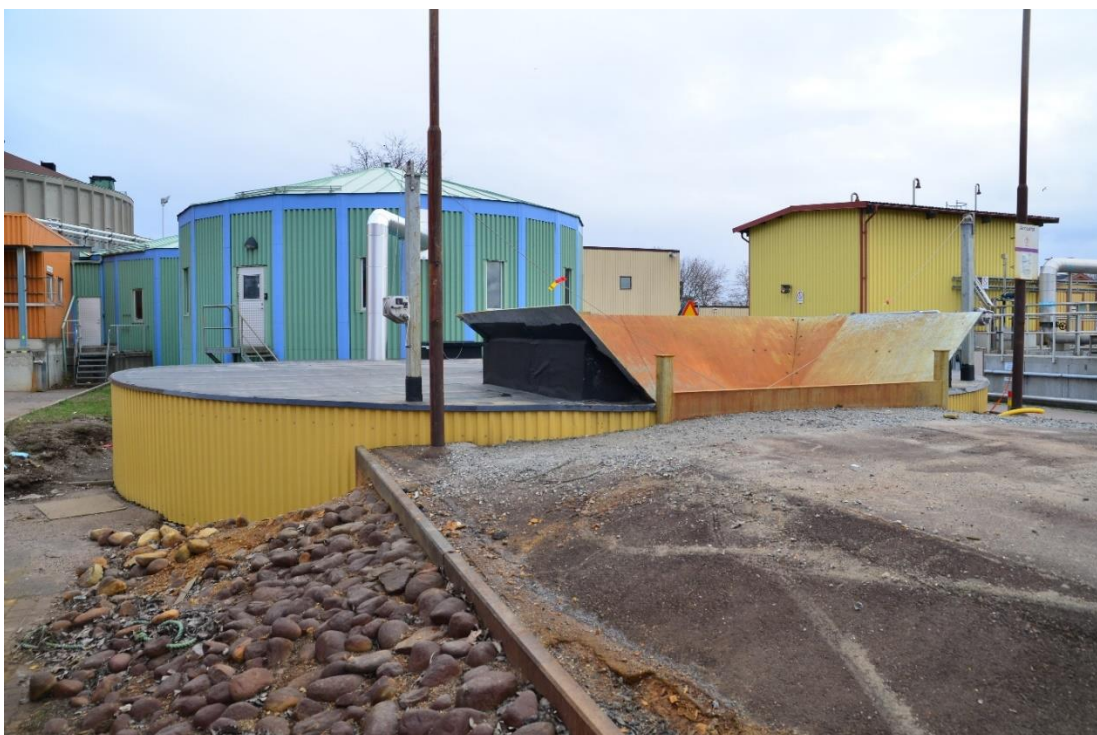
Figur 5. Järnsulfatupplösaren. Foto: Michael Kämpenber.
