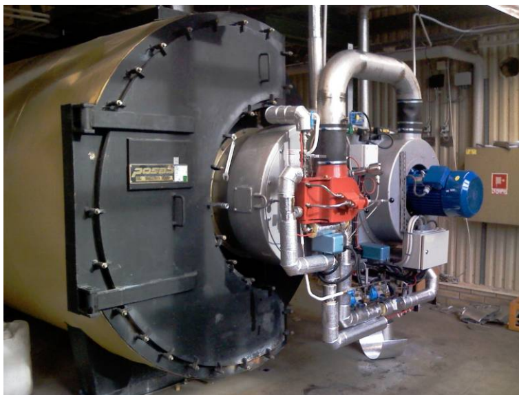
Panna 3 med nytt brännarsystem för eldning med tallbecksolja
