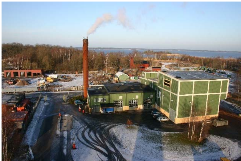
Hetvattencentralen i Kungsör, vy från söder
