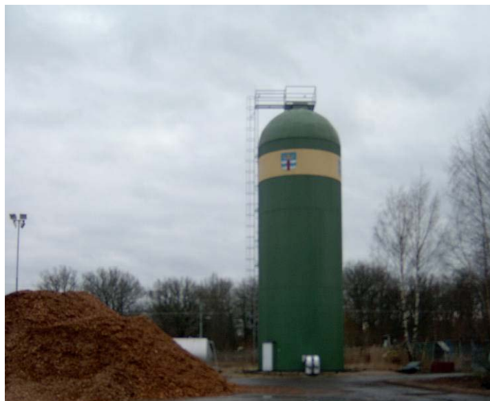
Figur 2 Hetvattenackumulator
