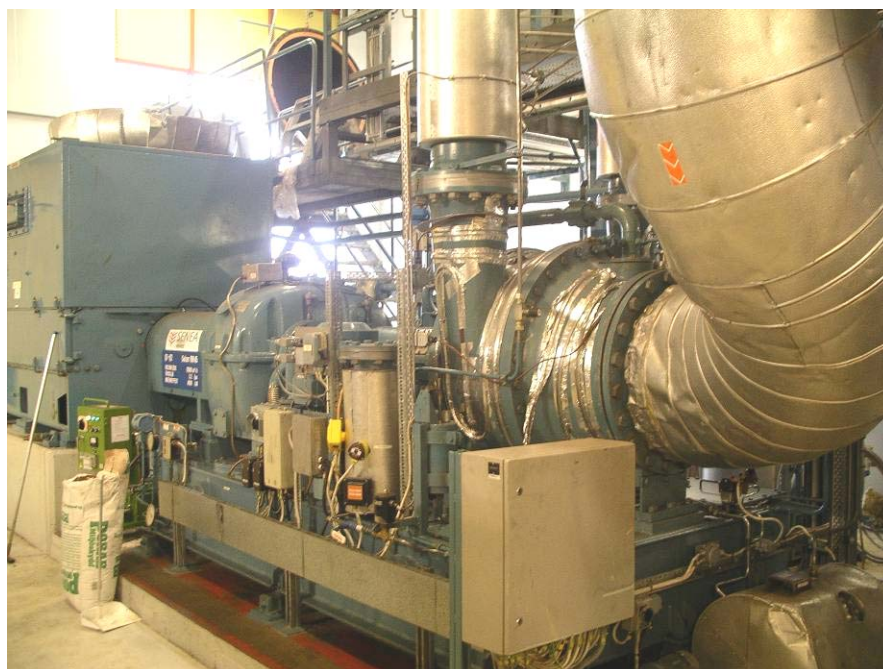
Elmotor och kompressor på Värmepump 2
