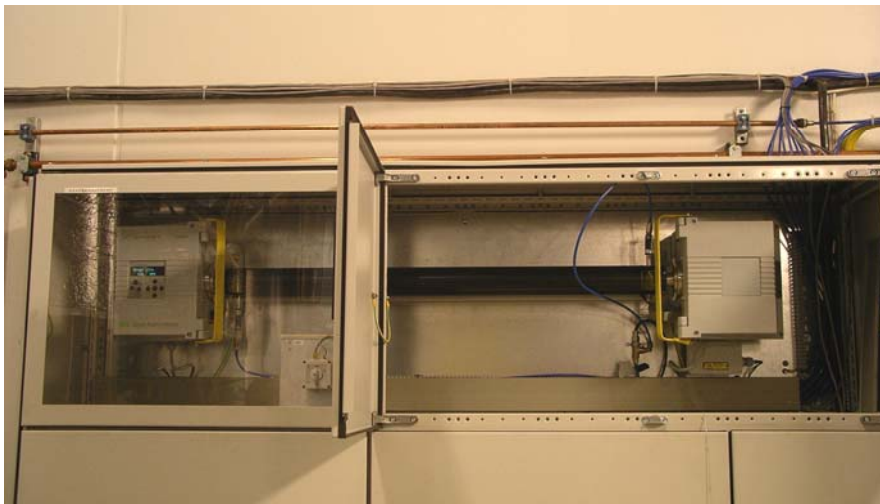
Instrumentet som mäter köldmediehalten på växelvisa punkter
