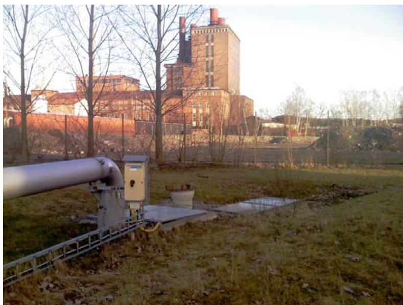
Kylvattenledningens uppåtgående del mot värmepumpanläggningen från Kraftverkskanalen
