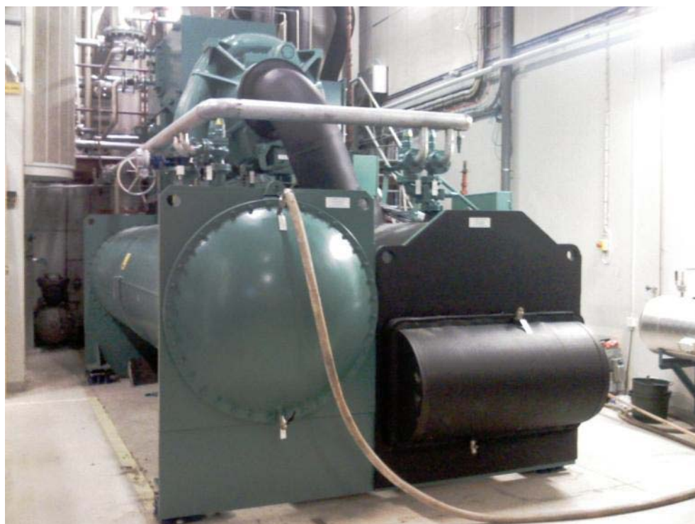
Figur 6 Vätskekyllaggregatet, Kylmaskin 4
