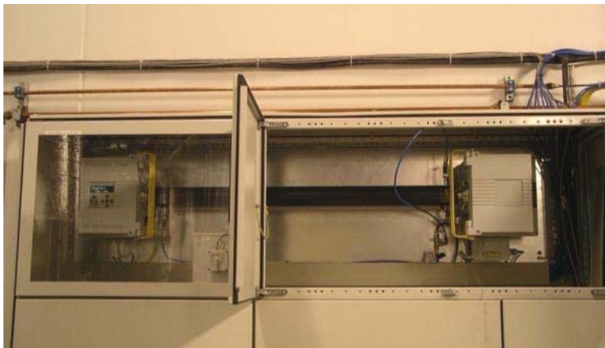
Figur 7 Instrumentet som mäter köldmediehalten på växelvisa punkter
