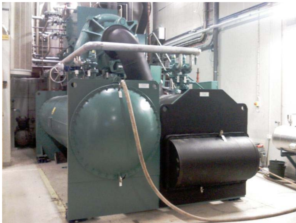
Figur 6 Vätskekylaggregatet, Kylmaskin 4
