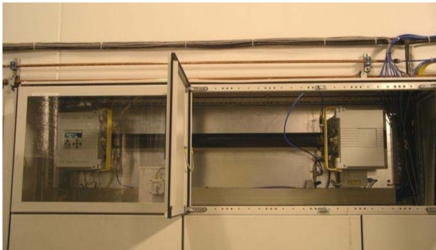
Figur 8 Instrumentet som mäter köldmediehalten på växelvisa punkter
