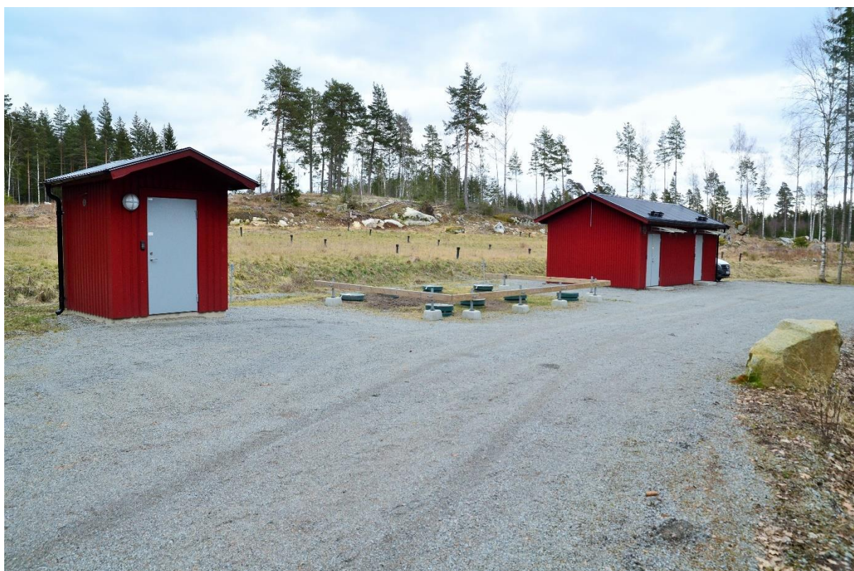
Figur 4. BDT-anläggningen i södra Munga. Foto: Michael Kämpenber.
