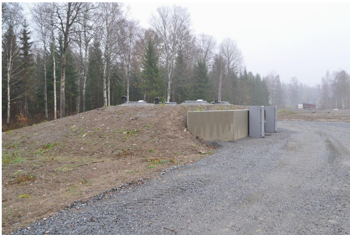
Figur 6. Klosettventankarna i norra Munga.
