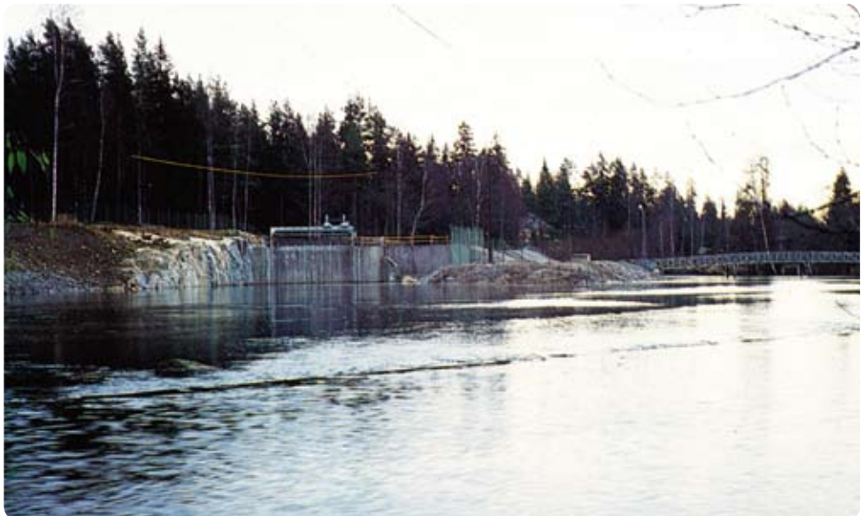
Intagskanal, intake canal
