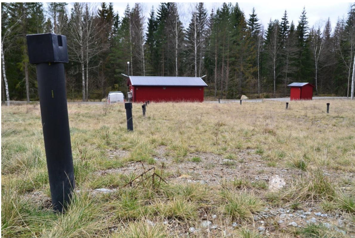
Figur 2.2. Luftningsrör i markbädd. Foto: Michael Kämpenberg.
