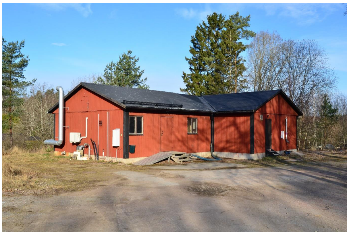
Figur 3. Flintavik reningsverk. Foto: Michael Kämpenber.
