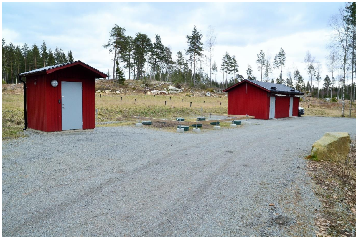
Figur 4. BDT-anläggningen i södra Munga. Foto: Michael Kämpenber.
