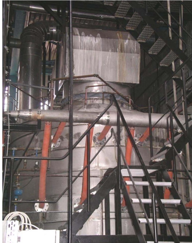
Figur 1 Toppen på skrubbern med inlopp för dysvatten
