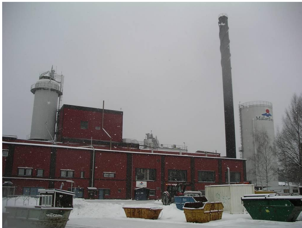
Figur 1 Hetvattencentralen i Hallstahammar, vy från söder
