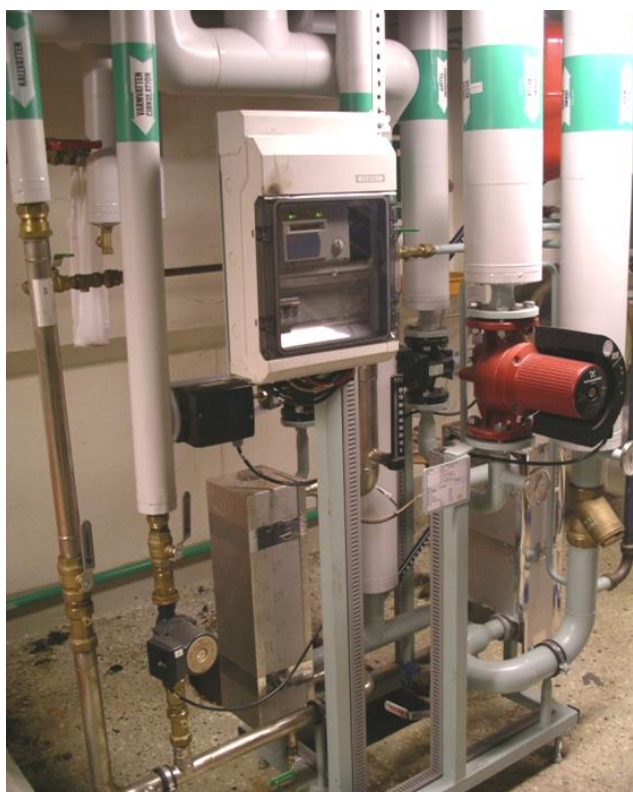
Figur 4 Inkoppling av fjärrvärme i stället för spädvatten
