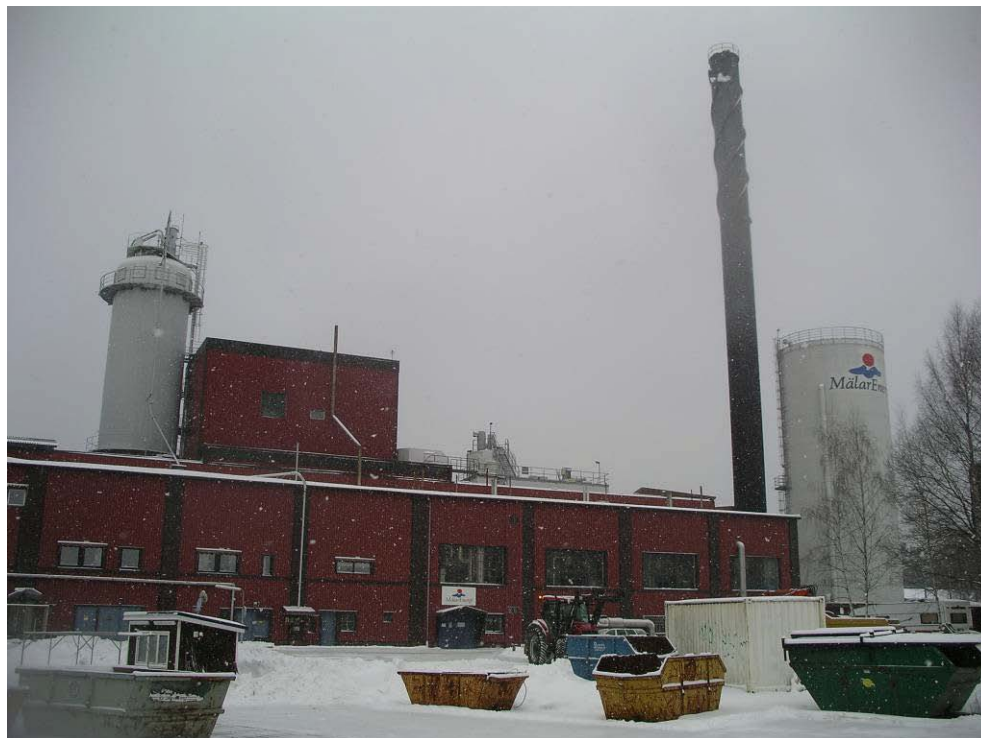
Figur 1 Hetvattencentralen i Hallstahammar, vy från söder
