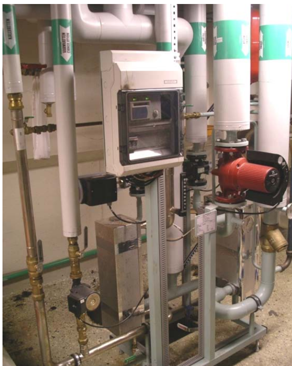
Figur 4 Inkoppling av fjärrvärme i stället för spädvatten
