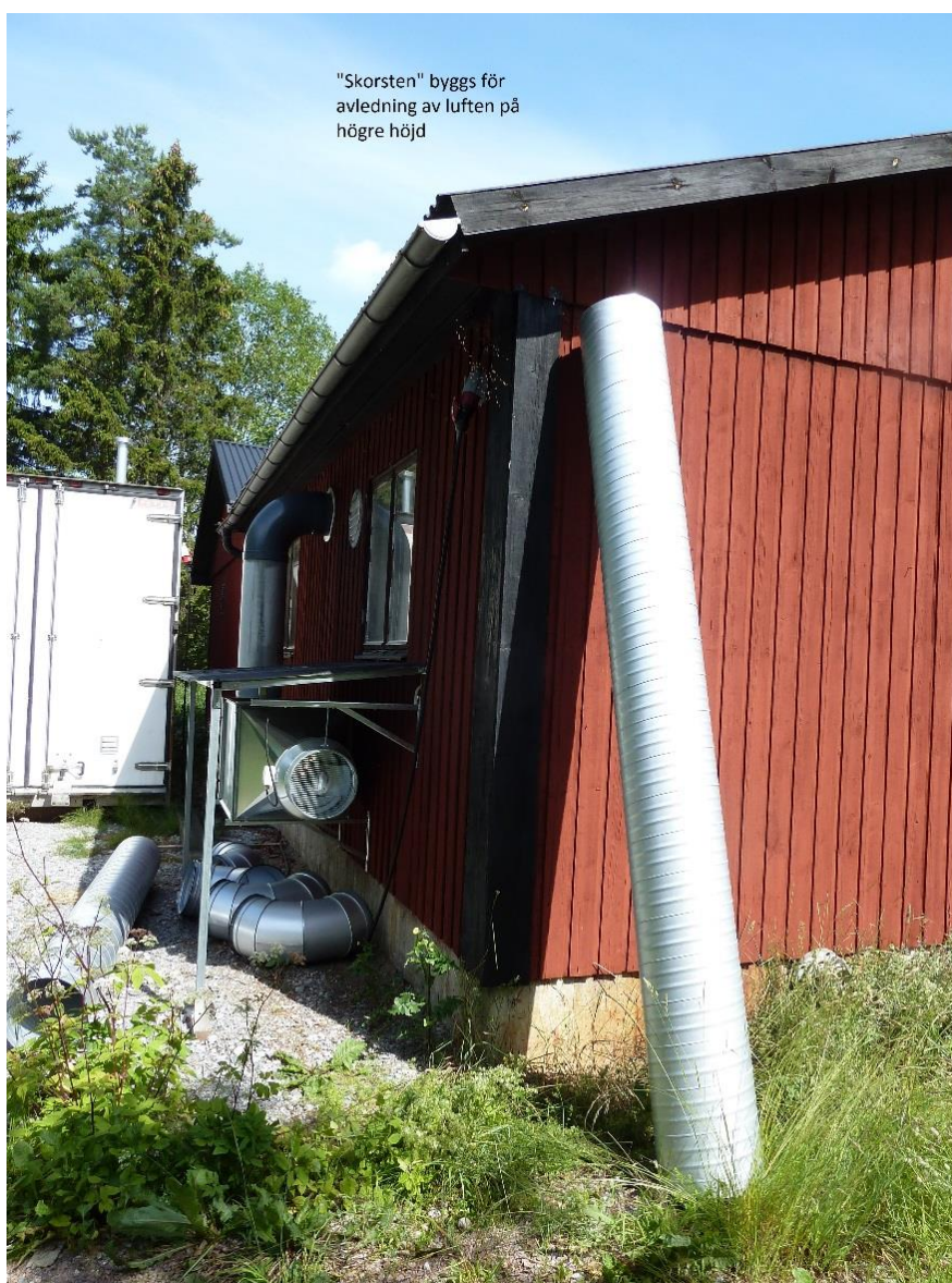
Figur 2. Byggnation av frånluftsventilation.
