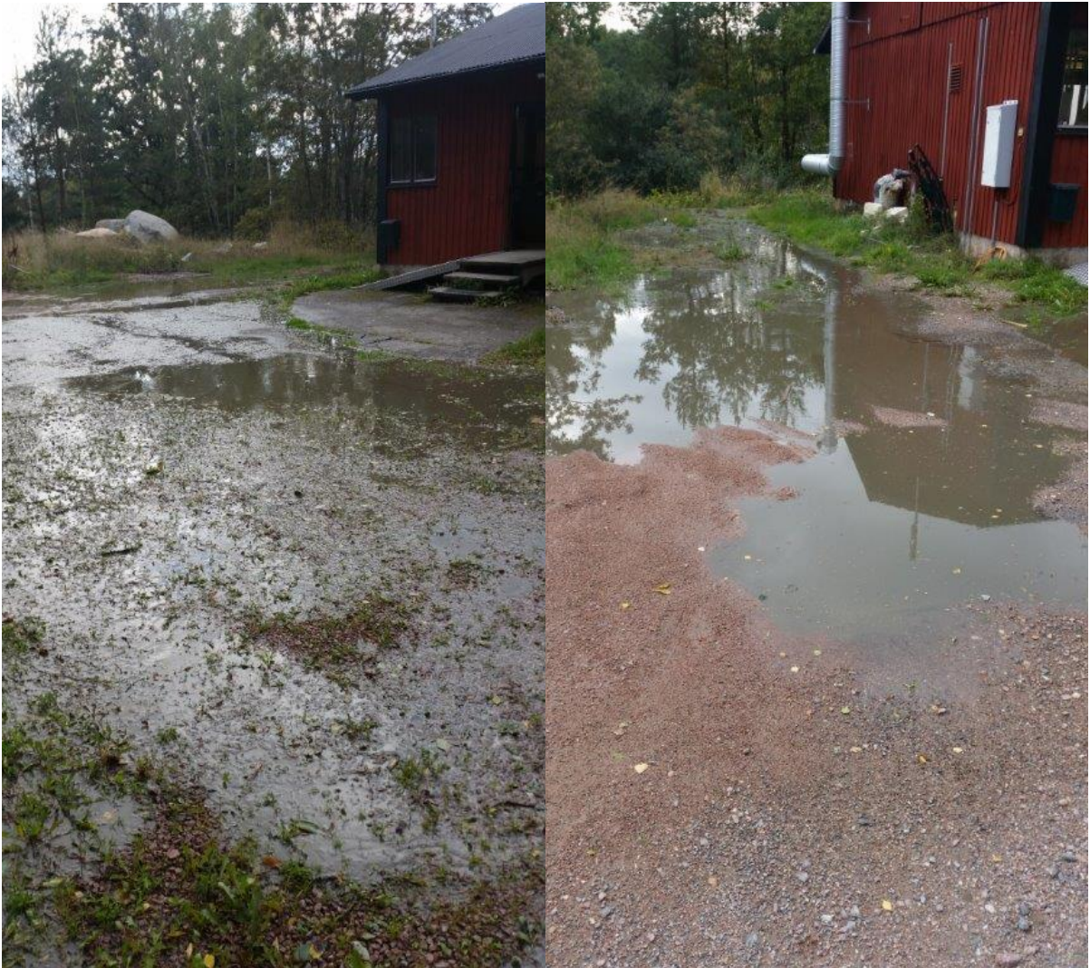
Figur 3. Slamvatten på gården utanför avloppsreningsverket. Foto: Peter Forsstedt.
