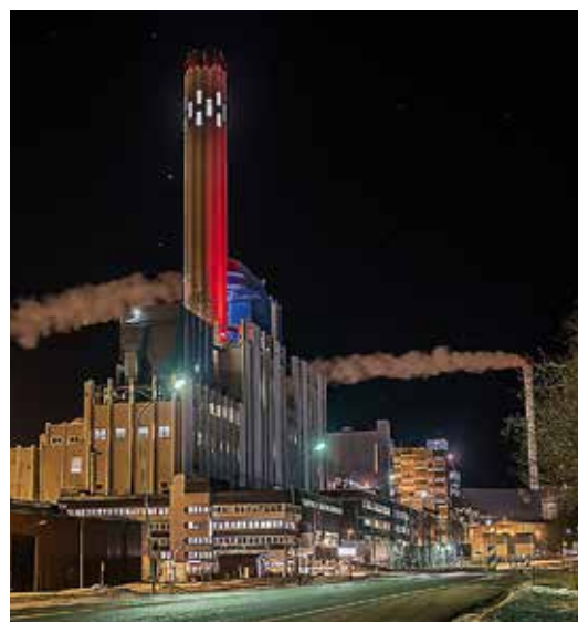
Bilden är tagen av Mikael Falk som uppmärksammade färgspelet på Kraftvärmeverket.
