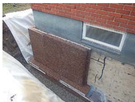
Yttreväggen har blåstrats ren och några små sprickor har lagats. Här sätts isolering upp på källarväggen för ett varmt och torrt inomhusklimat.
