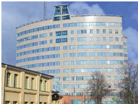
Mälarenergi installerar fjärrkyla för Hemfosa Fastigheter i kontorsfastigheten Sigurd 5 (Skatteskrapan) inför sommaren.
