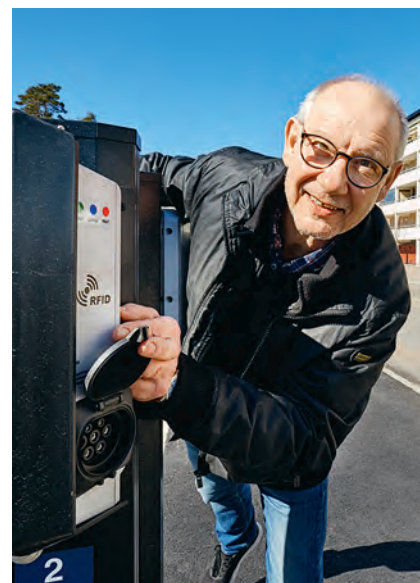
Sommaren 2018 installerade Brf Kolarhagen 43 elbilsaddare. Ulf Holgersson är föreningens fastighetsförvaltare och positiv till satsningen.
