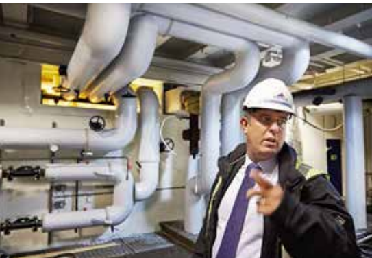
När den egna värmen inte räcker till kopplas Mälarenergis fjärrvärme enkelt in via en värmeväxlare på området.
